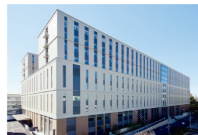
▲ 新病院棟外観
